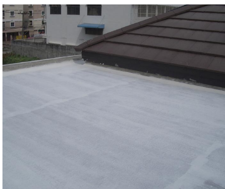
Nakładanie pierwszej warstwy.
