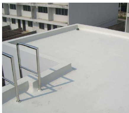
Gotowa powłoka hydroizolacyjna.
