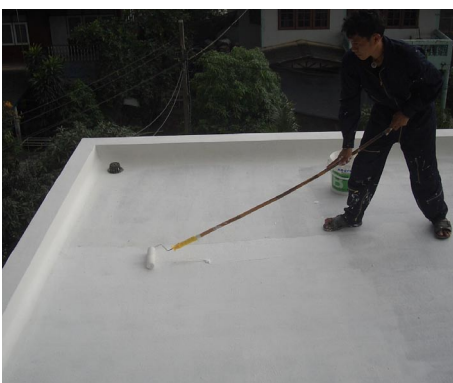
Nakładanie drugiej warstwy. Zatopienie siatki zbrojącej KÖSTER Armierungsgewebe w pierws- zej warstwie izolacji.
