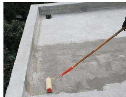
Gruntowanie podłoża preparatem KÖSTER Polysil® TG 500.
